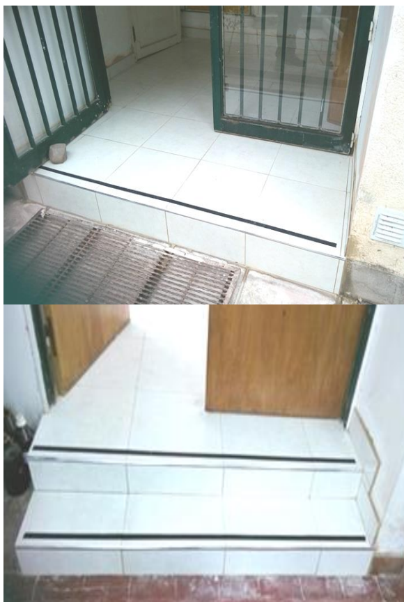
Foto N 2.- Colocación de cintas antideslizamiento en los escalones de ingreso a los laboratorios Químicos Central y de Química Analítica en el INTEMI
