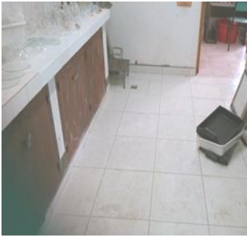
Foto N 5.- Colocación de cerámicos en el piso de la sala de campana del Laboratorio Químico Central del INTEMI
