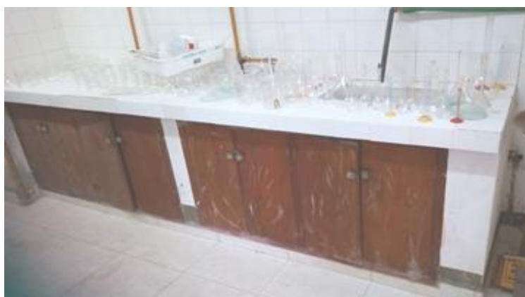
Foto N 4.- Reemplazo de azulejos por cerámicos en pileta y mesadas ubicados en la sala de campana en el Laboratorio Químico Central del INTEMI
